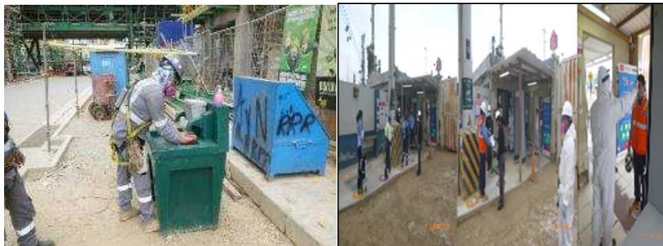
Figura 11. Medidas de protección colectiva.
