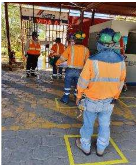
Figura 05. Control de accesos a la instalación
